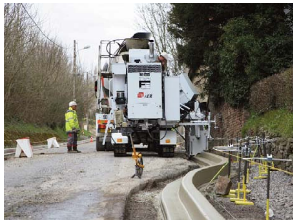
Coulage d'une bordure par machine à coffrage glissant asservie sur fils
