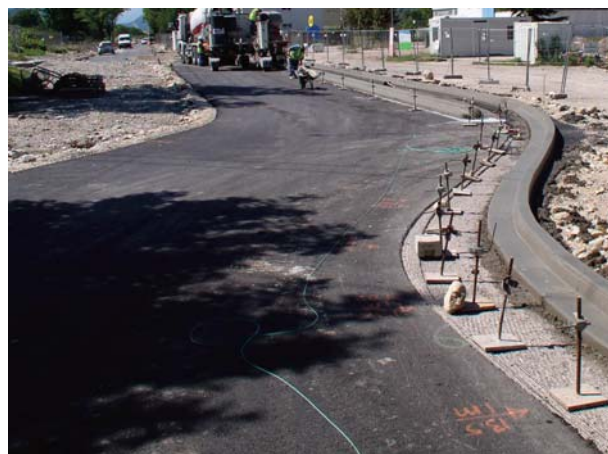
Extrusion par vibration
