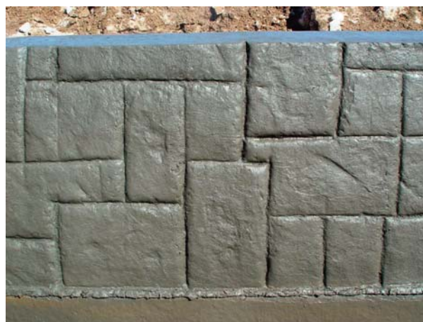
Impression du béton façon « pierre » directement par l'extrudeuse
