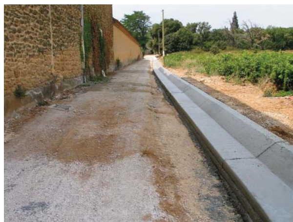
Bordure-caniveau sur voirie rurale
