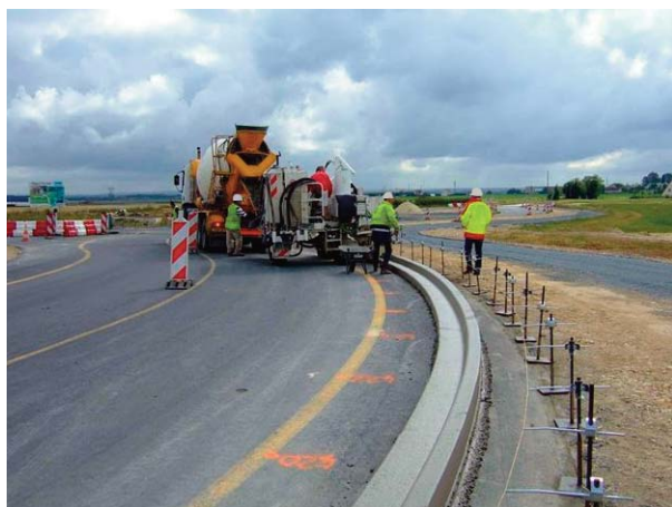
Coulage bordure-caniveau type T2CS3
