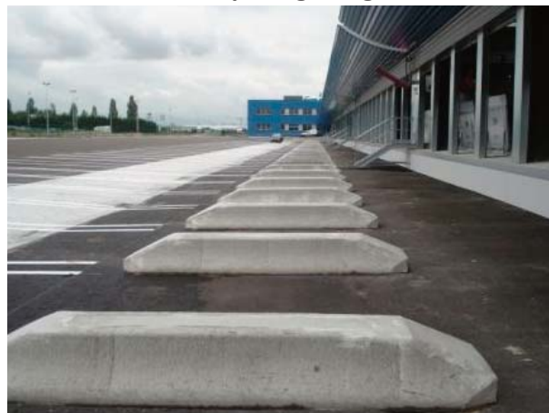
Ilot de guidage sur quai de déchargement PL
