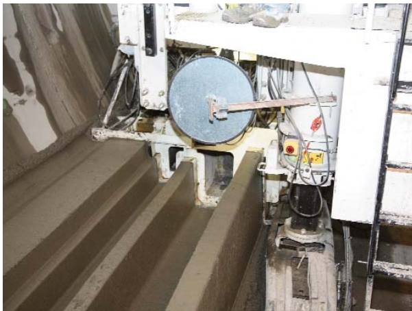
Accotement en tunnel
