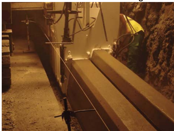
Caniveau-bordure à fente en tunnel
