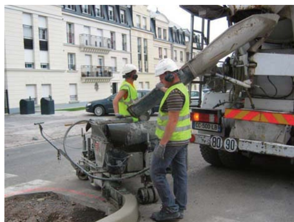
Coulage d'une bordure à l'extrudeuse par vis
