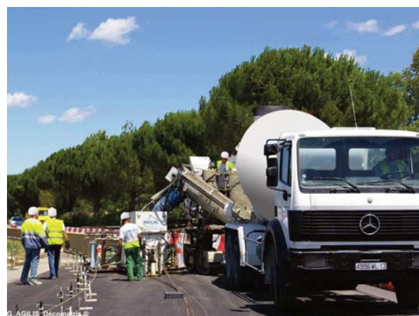
Livraison par camion malaxeur
