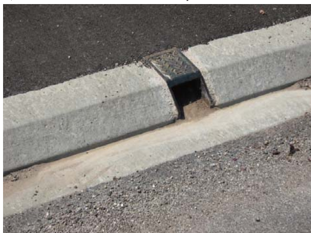
Intégration d'avaloir en fonte dans une bordure-caniveau
