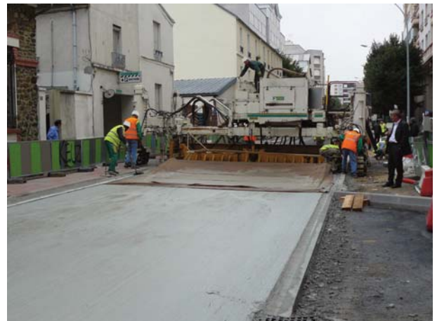
Bordure-caniveau et chaussée en béton dépolluant
