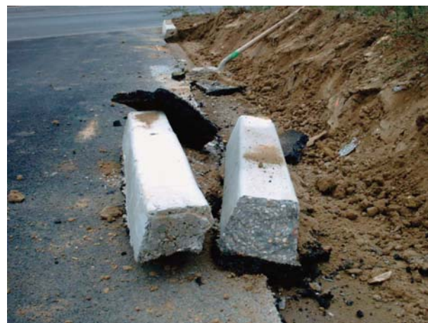
Accrochage béton/enrobé
