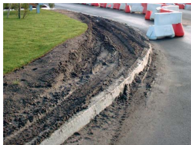
Franchissement d'une bordure T2
