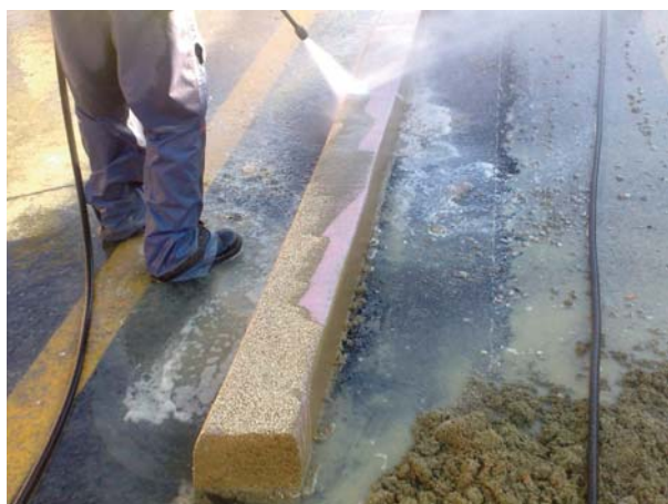
Désactivation d'une bordure en béton de mignonnette
