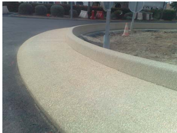
Bordure en îlot central de giratoire
