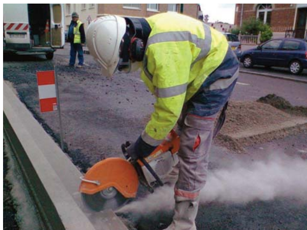
Sciage d'un joint de retrait/flexion
