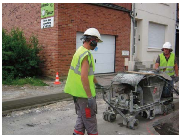
Extrusion par vis
